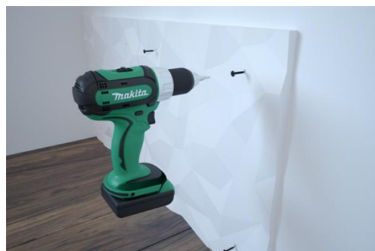
10. zet de 3D-panelen vast met schroeven.
