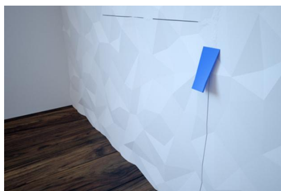
12. Vul de naden tussen de 3d-panelen op met een plamuurpasta. Schuur de naden na het drogen en uitharden glad met schuurpapier (180-240). Herhaal totdat het oppervlak volledig egaal is.
