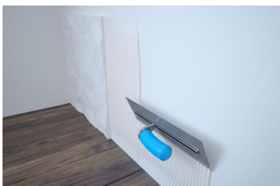
9. Breng een gipsgebonden lijm aan op de plek waar het paneel wordt gemonteerd. Deze lijm wordt achteraf ook gebruikt om de naad tussen de panelen op te vullen en glad te strijken. Breng de lijm aan met een tandspatel. Het is het beste als de lijm tijdens het plaatsen van de panelen licht uit de naden puilt, zodat er geen holle ruimtes tussen de panelen ontstaan. Wij raden hiervoor Knauf Uniflott aan.
